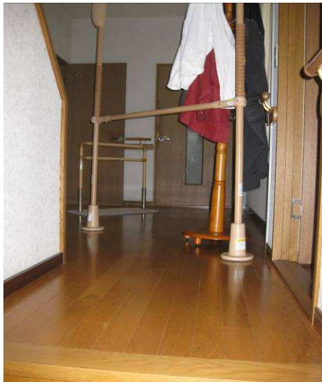
図 3. 階段から見た廊下の手すり設置位置
